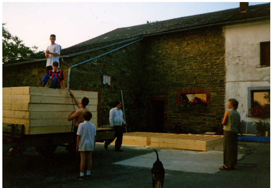
Verladen der ersten sechs Bodenelemente
