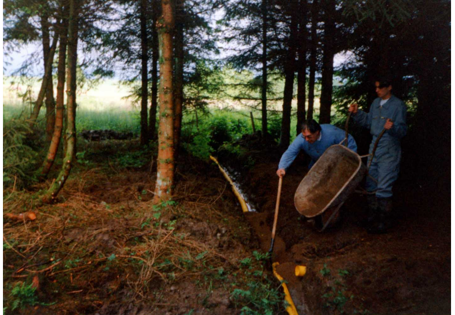
Verfüllen eines Entwässerungsgrabens
